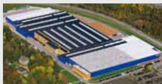
Hörmann KG Eckelhausen, Allemagne
